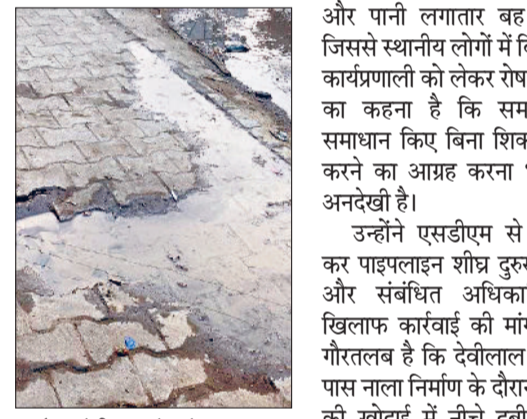
गन्जौर। देवीलाल चौक के पास सड़क पर बह रहा पेयजल सप्लाई का पानी।
